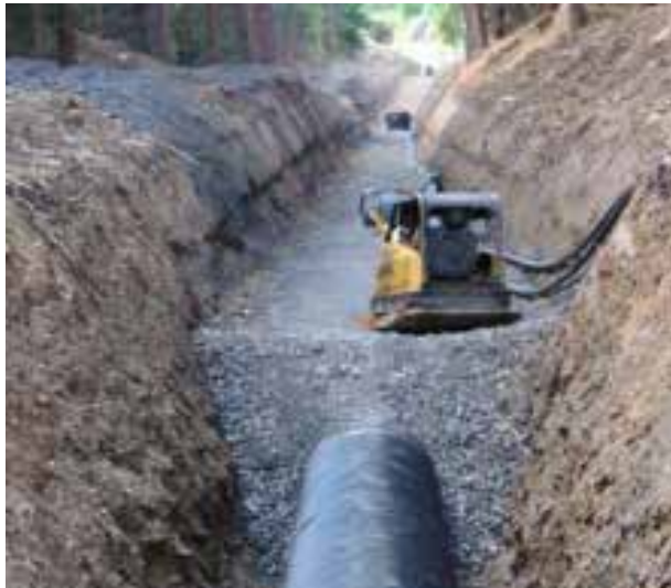
Foto 9.8-1: Relleno y compactación área del tubo.
