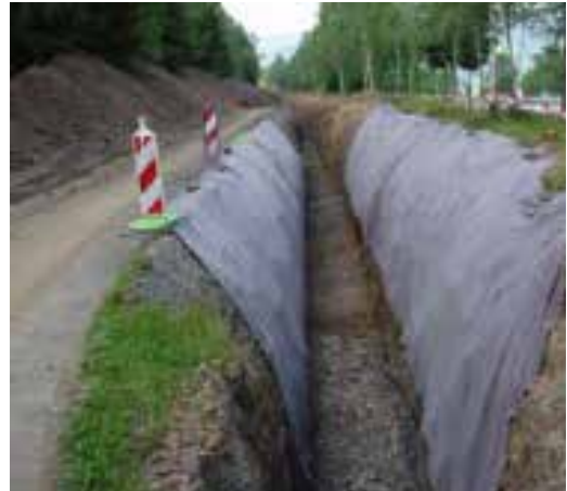
Foto 9.7-1: Uso de Geotextiles.
