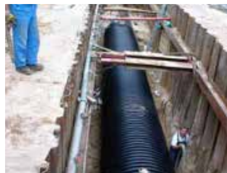
Foto 9.2-1: Apuntalamiento de la zanja.
