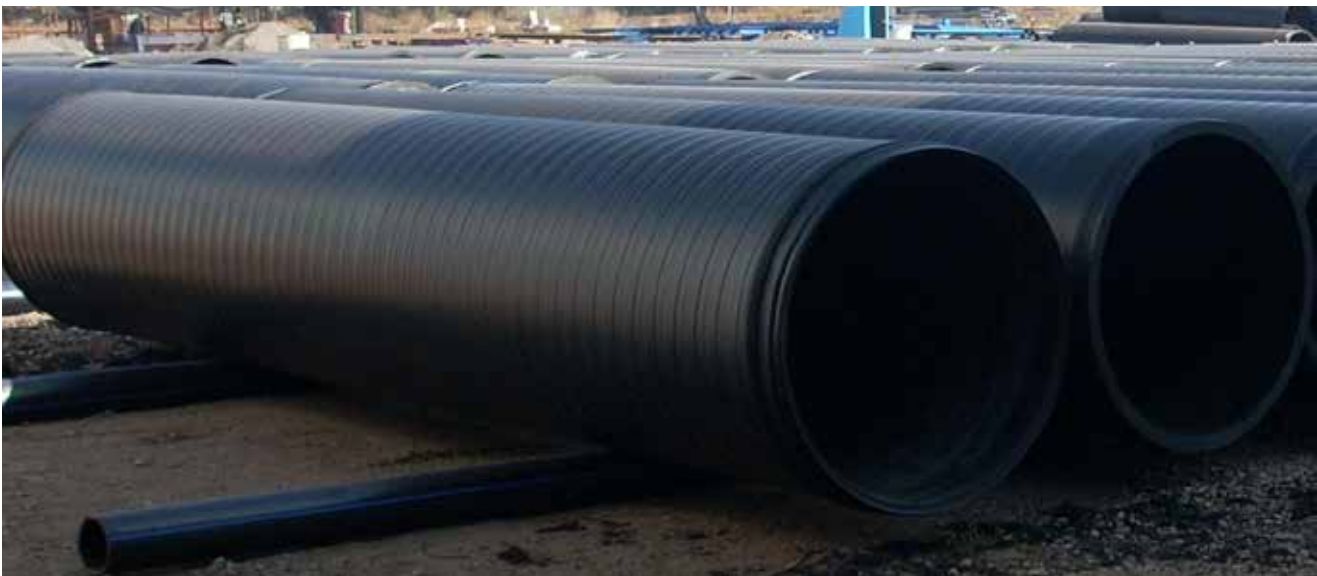
Foto 6.5-1: Suministro Tuberías KRAH® PE 200
