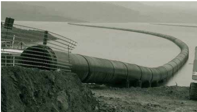
Foto 6.6-2: Instalación de tubería KRAH® PE 200; Aducción Agua Potable
