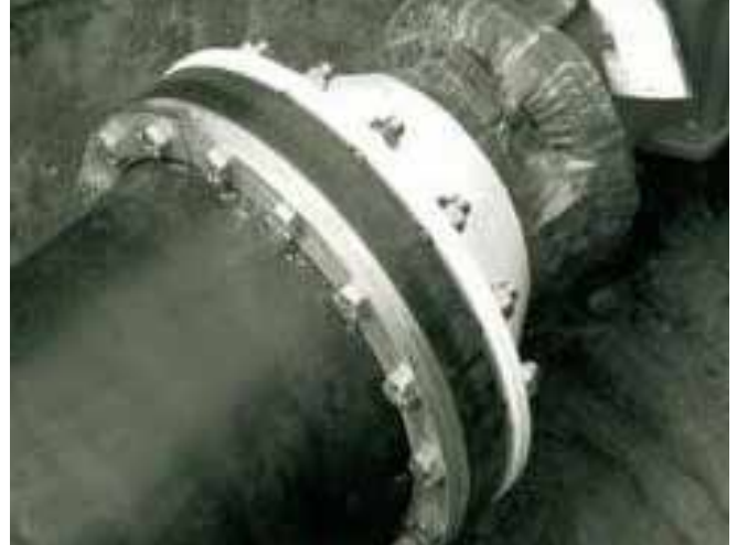
Foto 6.6-1: Instalación de Tubería KRAH® PE 200; Alimentadora A.P. Brie
