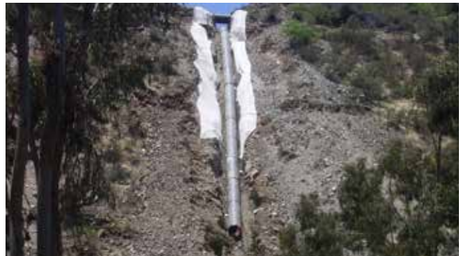
Foto 6.6-3: Instalación de tubería KRAH® PE 200; Sifón Agua de Riego.
