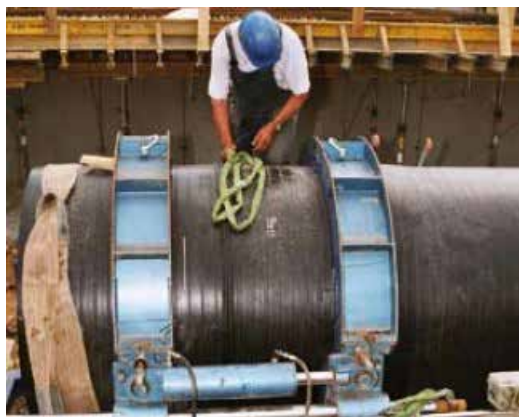
Foto 6.3-1: Soldadura a Tope.
