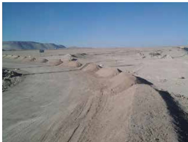
Foto 6.6-4: Instalación de tubería KRAH® PE 200 en Mina Ministro Hales; Impulsión Agua Subterránea
