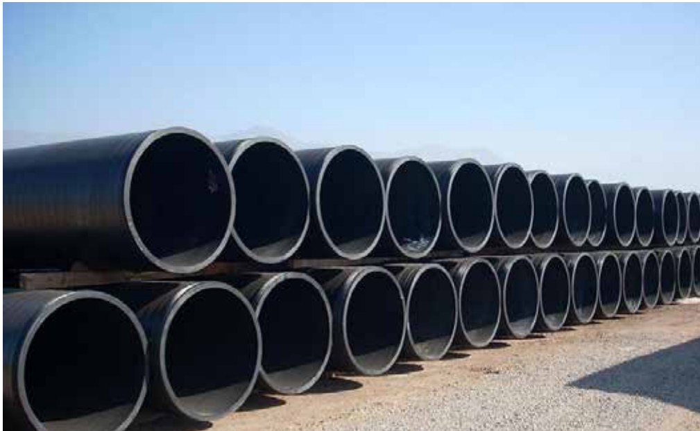
Foto 6.5-2: Acopio Tuberías KRAH® PE 200
