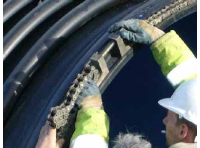
Foto 5.3-4: Electrofundición de tuberías KRAH®. Vista cadena externa.
