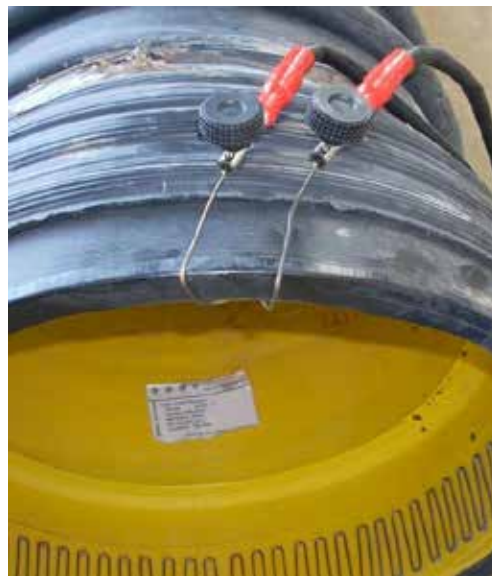
Foto 5.3-5: Electrofundición de tuberías KRAH®. Vista bornes de conexión.
