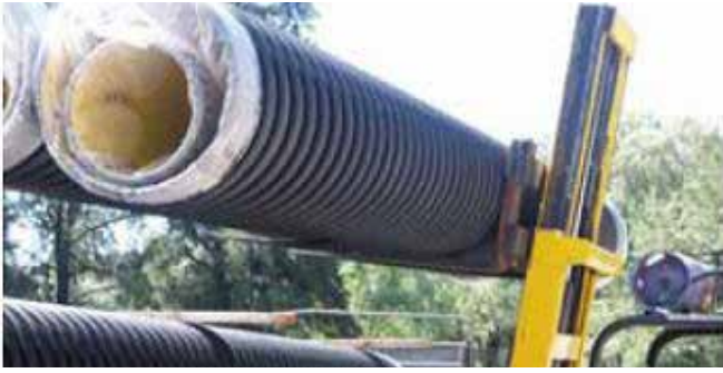
Foto 5.3-1: Manipulación Tubería Estructurada
