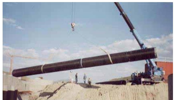
Foto 5.5-1: Izaje de tuberías acopladas
