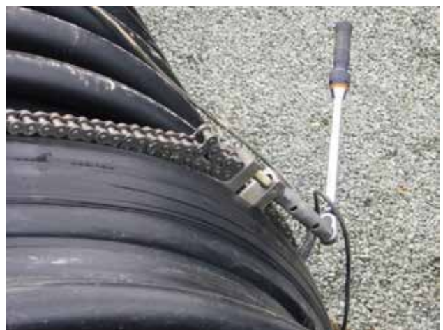
Foto 5.3-7: Electrofusión de tuberías KRAH®. Vista Fleje externo y conexionado eléctrico.
