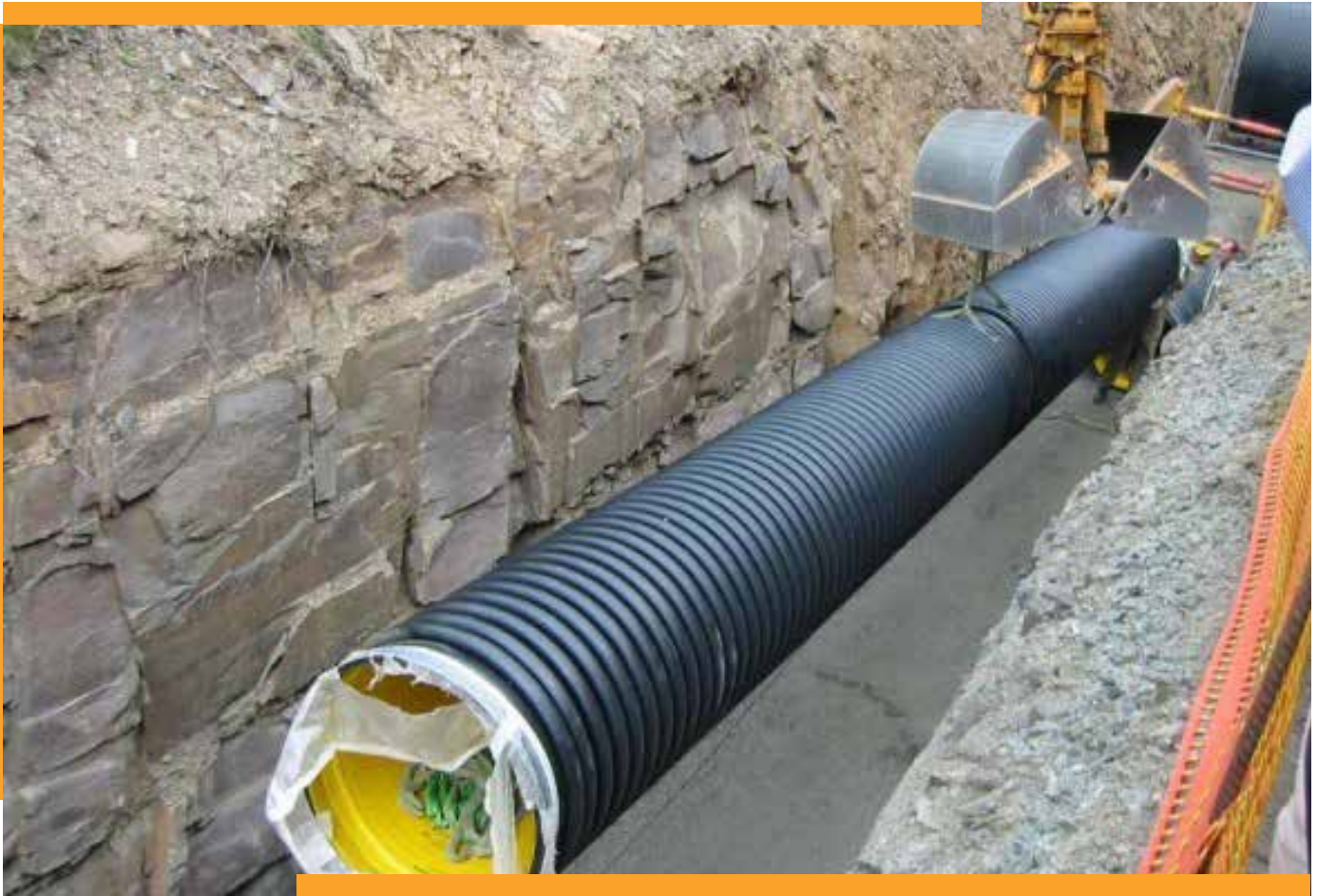
Foto 2.2 Tuberías Pared Estructurada
